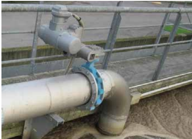
Valvola a farfalla - Coefficiente di portata
