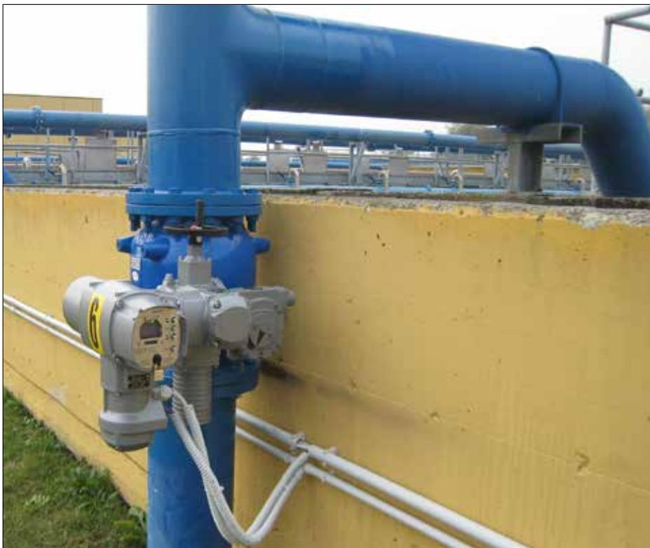
Fig.1 - Valvola a fuso F500 e F560 TIS-AIR per regolazione del flusso di aria all'interno di vasche di ossidazione.
